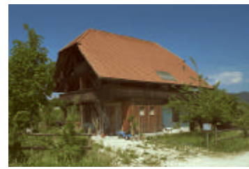
I.11 Wohnstock Wyss mit Speicheraufbau, Hauptstrasse 35
