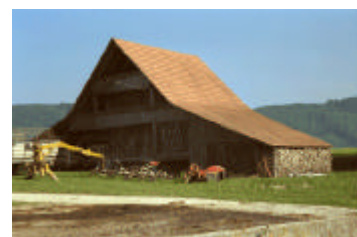
I.21 Speicher Nr. 28 bei Ramsernstrasse 101
