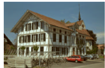
I.16 Altes Schulhaus, Räzlrain 2
