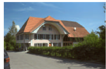
3.11 Wohnhaus Burkhard/ Derron/Zaugg, Hauptstrasse 29
