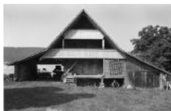
I.21 Speicher Nr. 28 bei Ramsernstrasse 101
