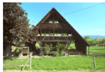
1.1 Speicher Dick, Hauptstrasse 15 a
