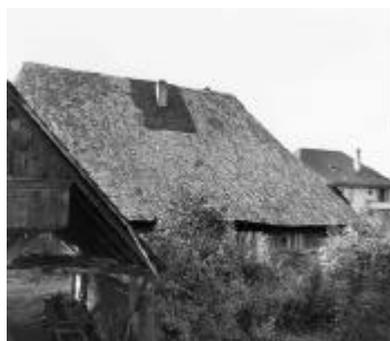
1.3 Bauernhaus Isch, Hauptstrasse 30
