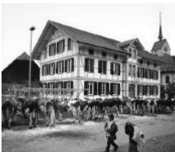
I.16 Altes Schulhaus, Räzlrain 2
