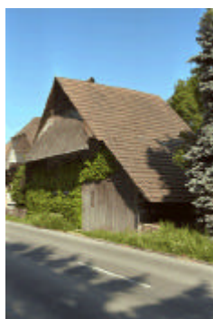
2.2 Speicher Wanner, Hauptstrasse 11 a
