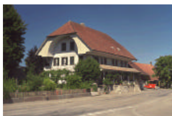
1.2 Ehemaliges Bauernhaus Nr. 153, Hauptstrasse 17
