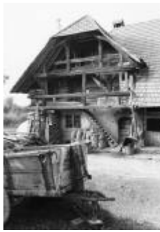
I.11 Wohnstock Wyss mit Speicheraufbau, Hauptstrasse 35
