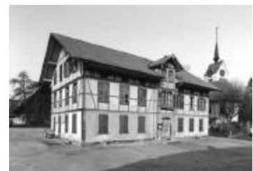
I.16 Altes Schulhaus, Räzlrain 2
