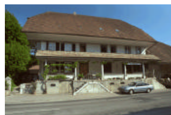
1.2 Ehemaliges Bauernhaus Nr. 153, Hauptstrasse 17
