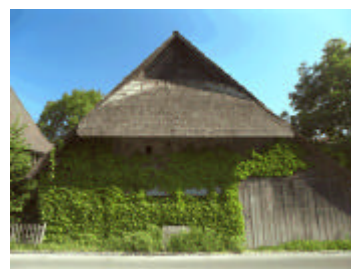
2.2 Speicher Wanner, Hauptstrasse 11 a
