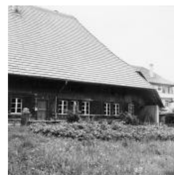
1.3 Bauernhaus Isch, Hauptstrasse 30
