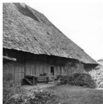
1.3 Bauernhaus Isch, Hauptstrasse 30
