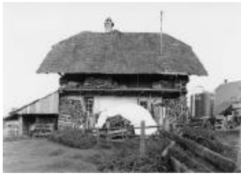
I.11 Wohnstock Wyss mit Speicheraufbau, Hauptstrasse 35
