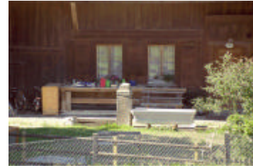
I.3 Bauernhaus Isch, Hauptstrasse 30
