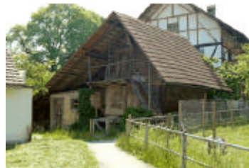
3.10 Speicher Andres, Hauptstrasse 40 a
