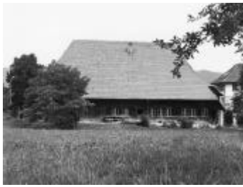
I.3 Bauernhaus Isch, Hauptstrasse 30
