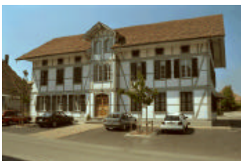
I.16 Altes Schulhaus, Räzlrain 2
