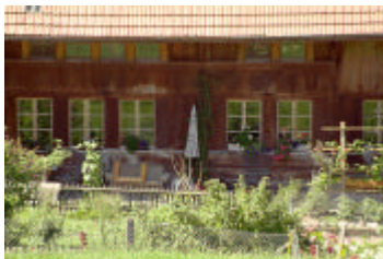
I.3 Bauernhaus Isch, Hauptstrasse 30
