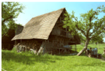
3.25 Speicher, Pfarrweg 5 b
