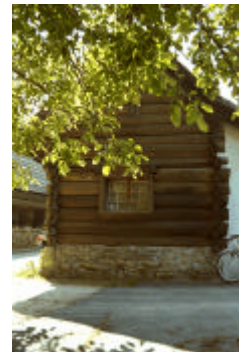
I.19 Speicher Ziegler, Hubelweg 3
