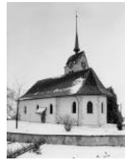
I.7 Kirche und Kirchturm, Hauptstrasse 44
