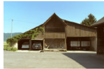
3.17 Speicher Schluep bei Ramsernstrasse I b
