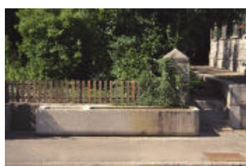
5.1 Brunnen beim Geschäftshaus Stoll, Hauptstrasse 17
