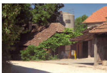
2.3 Nebengebäude Wanner, Hauptstrasse 11 b
