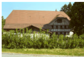
3.33 Bauernhaus Aregger/Benkler, Rätzlirain 14
