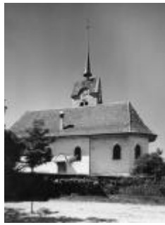
I.7 Kirche und Kirchturm, Hauptstrasse 44
