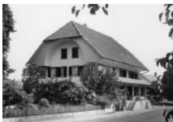
1.2 Ehemaliges Bauernhaus Nr. 153, Hauptstrasse 17
