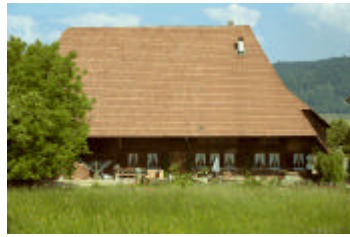
I.3 Bauernhaus Isch, Hauptstrasse 30
